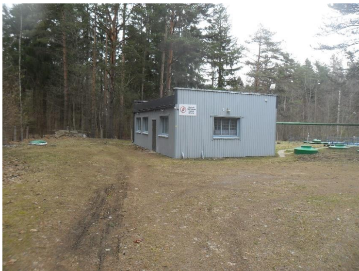
Joonis 6-12 Voka reoveepuhasti tehnohoone välisilme, paremal näha voolurahustuskaevude luugid
