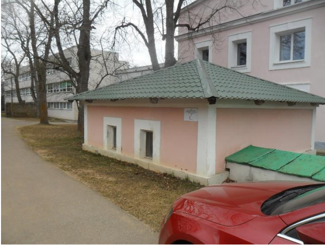
Joonis 5-6 Gümnaasiumi puurkaevpumpla välisvaade
