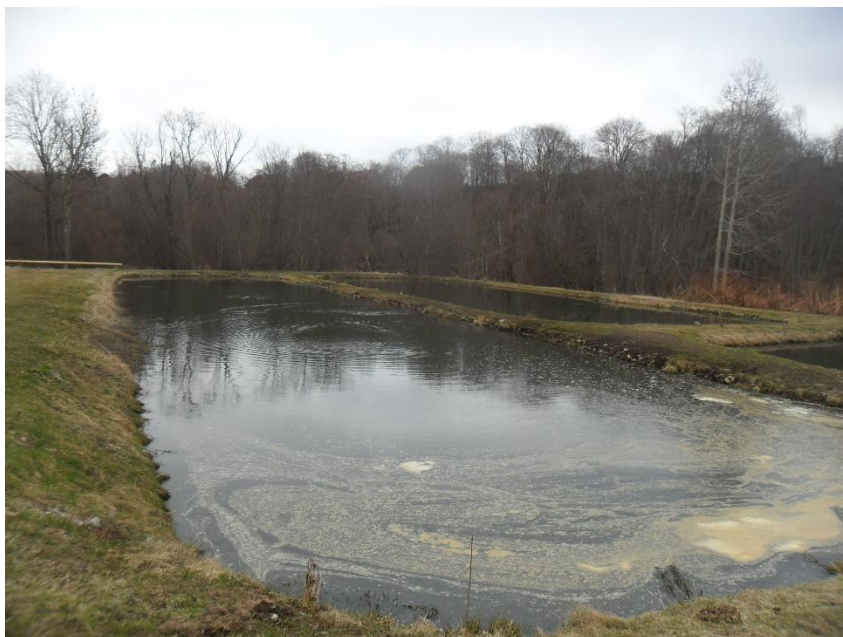
Joonis 6-6 Toila RVP biotiikide pinnal on Viru Rand OÜ-st tulnud rasvast tingitud vaht
