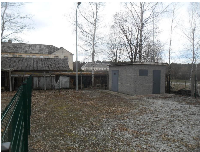
Joonis 6-14 Kohtla-Nõmme Klubi reoveepumpla välisvaade (katusel on näha suundantenn info kaugedastuseks)
