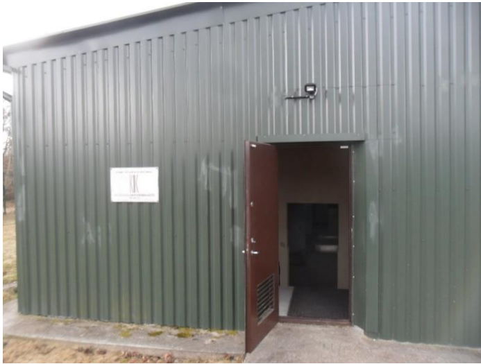
Joonis 5-21 Kohtla-Nõmme veevarustuspumpla ja VTJ välisvaade
