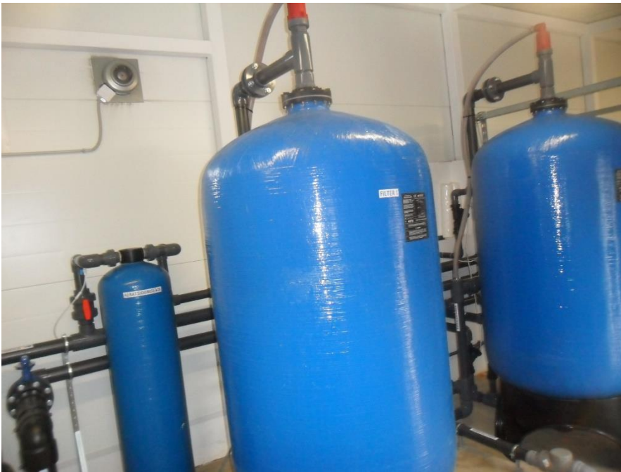
Joonis 5-2 Toila Nõlva veevarustuspumpla sisesvaade (vasakult: aeratsioonimahuti, edasi kaks Fe- ja Mn survefiltrit
