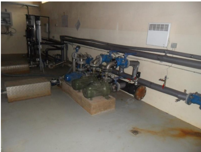
Joonis 5-23 Kohtla-Nõmme VTJ II astme pumbad ja uhteveepump
