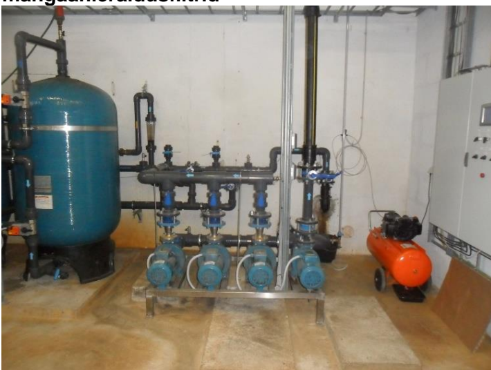
Joonis 5-17 Voka peapumpla, VTJ II astme pumbad
