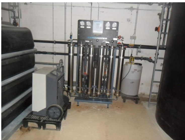
Joonis 5-13 PO-seadmed (vasaule jääb pesuveemahuti, paremale puhtaveereservuaar)
