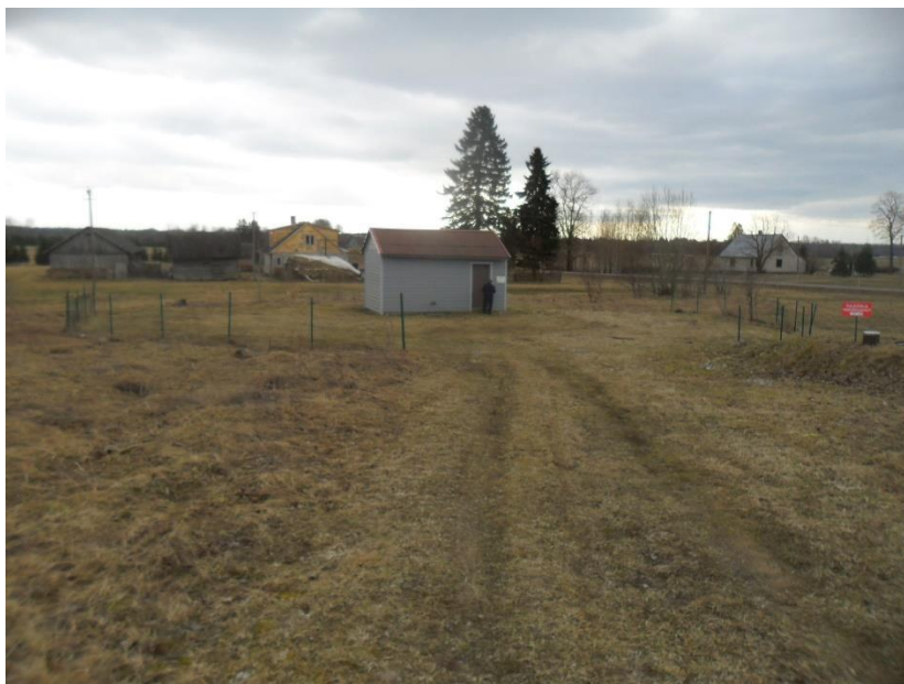
Joonis 5-27 Vitsiku pk pumpila välisvaade, paremal tuletõrjeveevõtukoht
