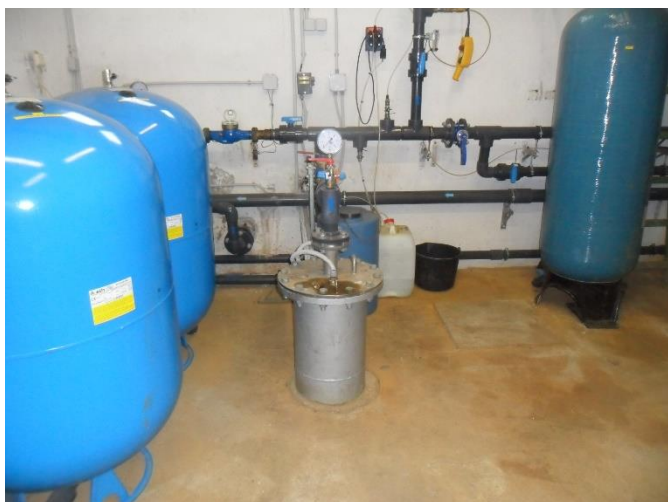
Joonis 5-18 reservpuurkaev nr 2466 päis paikneb VTJ hoones, vasakul hüdrofoorid 2x500 l
