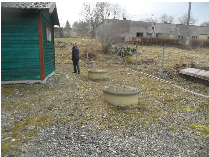
Joonis 6-8 Gümnaasiumi reoveepuhasti septiku maapealsed luugid
