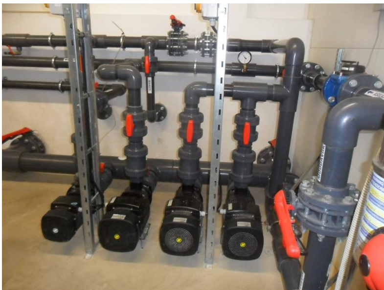
Joonis 5-3 Paremalt II astme võrgupumbad, vasakul uhteväe- ja tuletõrjepump
