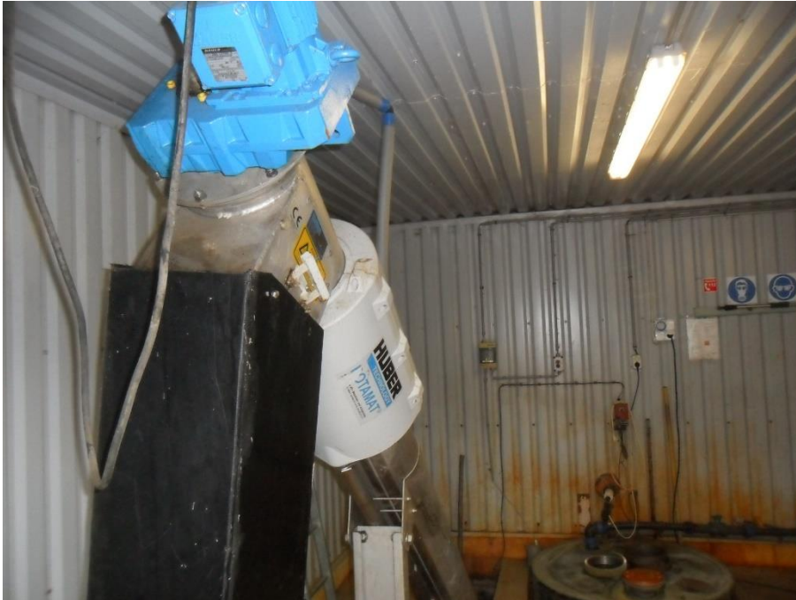
Joonis 6-4 Toila reoveepuhasti kruvivõre
