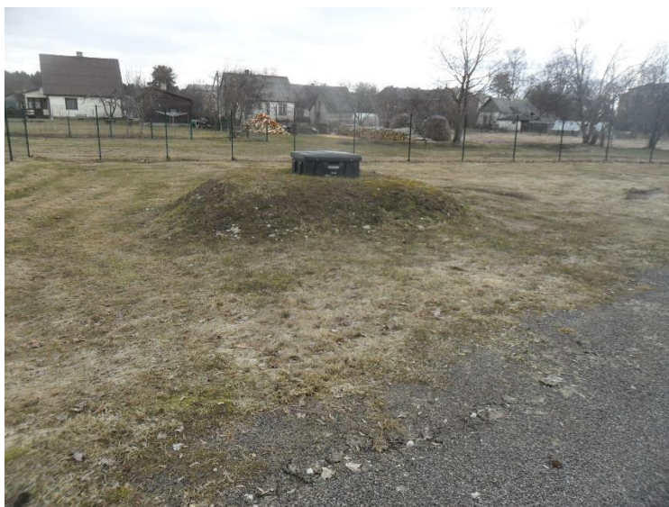
Joonis 5-19 Kohtla-Nõmme põhipuurkaevpumpla nr 54199 välisvaade
