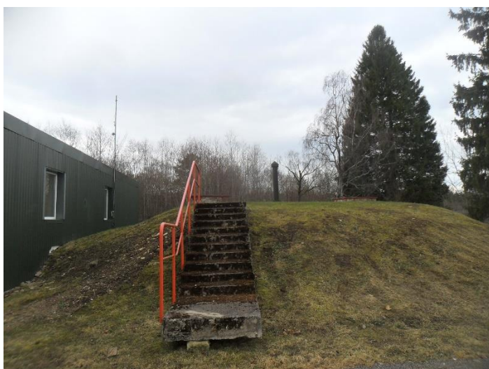
Joonis 5-24 Kohtla-Nõmme veevarustuspumpla veereservuaar muldes (100 m 3 )
