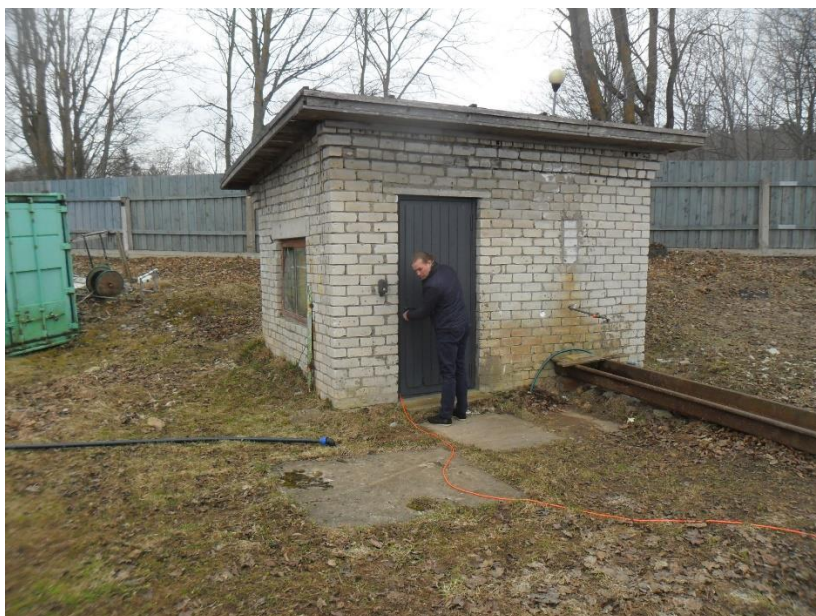
Joonis 5-4 Toila sadama puurkaevpumpala välisvaade
