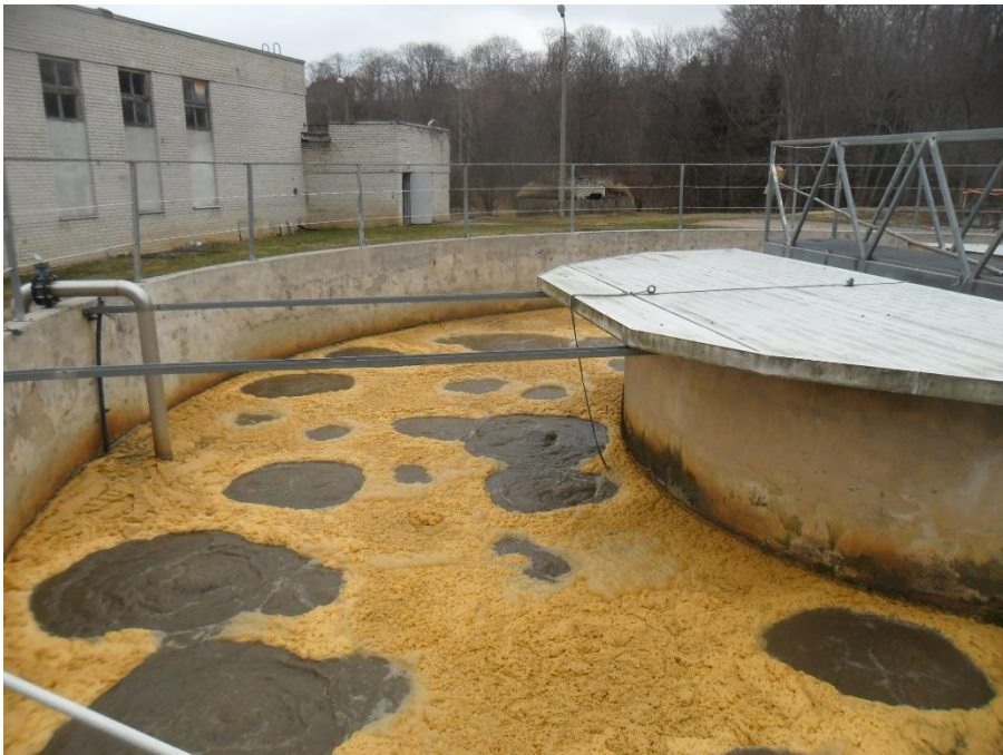
Joonis 6-5 Toila reoveepuhasti üks aerotankidest. Mark PRP-300 (järelsetiti asub keskel)
