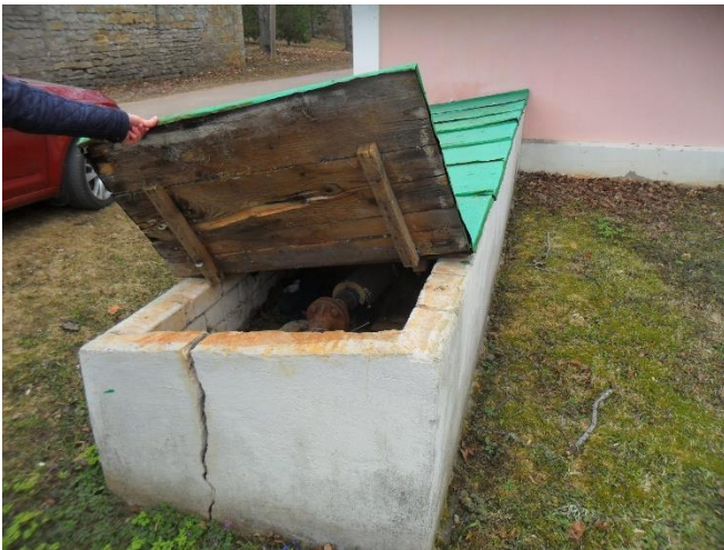
Joonis 5-7 Gümnaasiumi puurkaevu päisehitis
