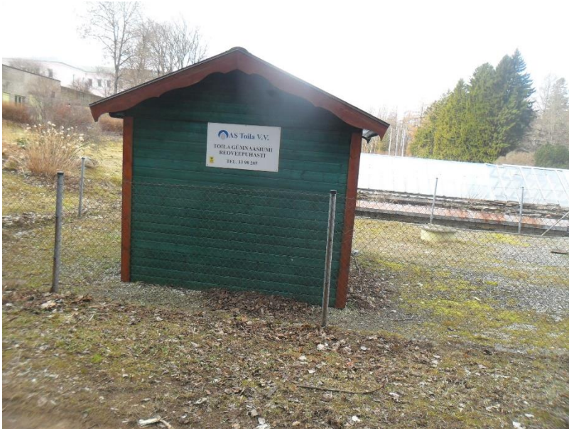
Joonis 6-7 Toila Gümnaasiumi reoveepuhasti tehnohoone välisvaade
