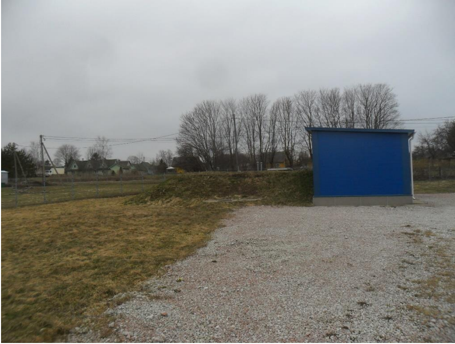
Joonis 5-1 Toila Nõlva veevarustuspumpla välisvaade. Hoone taga on näha puhtaveereservuaaride (2x150 m 3 ) muldkate
