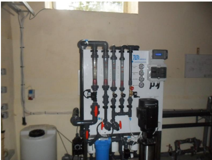
Joonis 5-22 Kohtla-Nõmme VTJ sisevaade, PO seadmed
